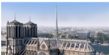
La flèche sera reconstruite dans l'esprit de celle de VIOLLET-LE-DUC, mais en titane, ajourée et torsadée « dans un geste d'élévation et d'énergie », selon les propos de l'architecte ; le coq et les 16 statues des apôtres et évangélistes, sauvées de l'incendie, y seront replacés à sa base et visible de la terrasse.
